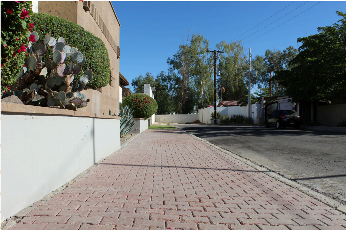
Imagen 2. Acera del Fraccionamiento Los Pinos
