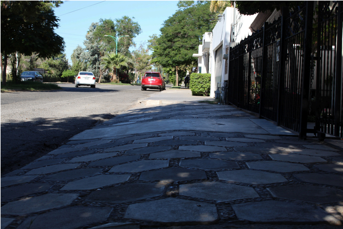
Imagen 1. Acera del Fraccionamiento Los Pinos
